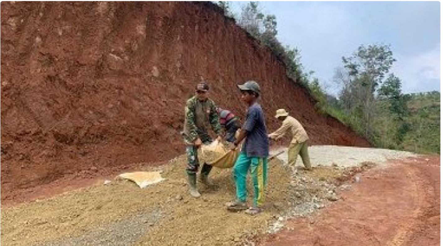
SOLOK - Pembangunan jalan usaha tani sepanjang 1.100 meter dengan lebar 6 meter dalam program TMMD ke-118 Kodim 0309/Solok yang sudah dimulai sejak tanggal 20 September 2023 lalu, sudah mulai memasuki tahap pengerasan badan jalan.
